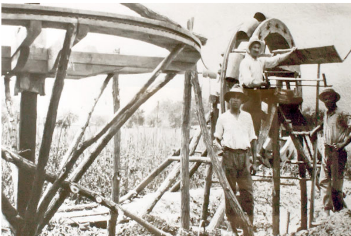
Construção de um dolap. Turquia, década de 1930
