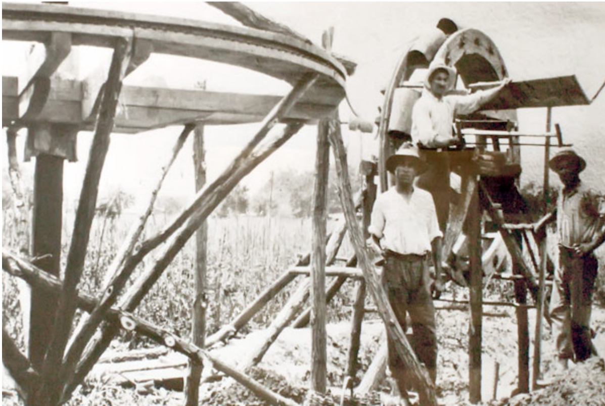
Bau eines Dolap. Türkei, 1930er Jahre
